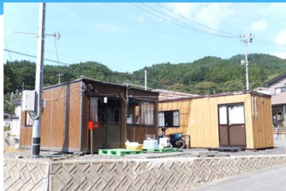
被災後の消防団写真1 第2分団第1部第2部仮設屯所 (左:分団でリース、右:町から貸与)
