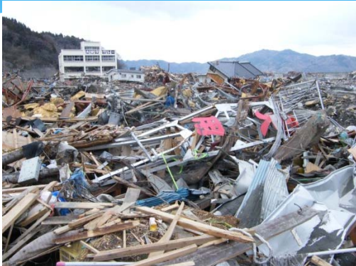
消防団被害写真2 流された第2分団第1部・第2部消防屯所の火の見櫓 (屯所は流失・全壊)
