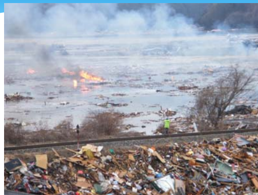
被災後の状況写真2 新港町地区 建物が燃えながら漂流
