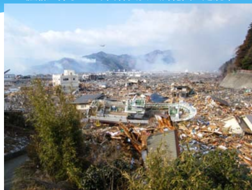
被災後の状況写真8 安渡地区の状況 漁船が打ち上がり山林火災が広範囲に延焼中
