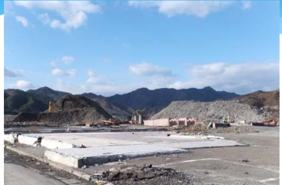
現在の大槌町の様子2 土砂山とコンクリート瓦礫の山(1/2)
