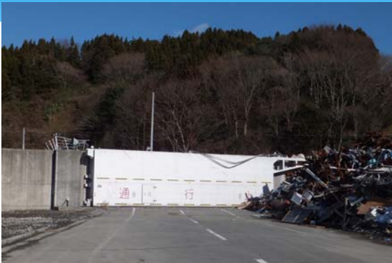
現在の大槌町の様子9 閉まったままの防潮堤水門(私が最初に閉めた門)
