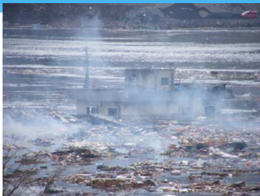
被災後の状況写真1 新港町地区 鉄筋コンクリート建物が残った
