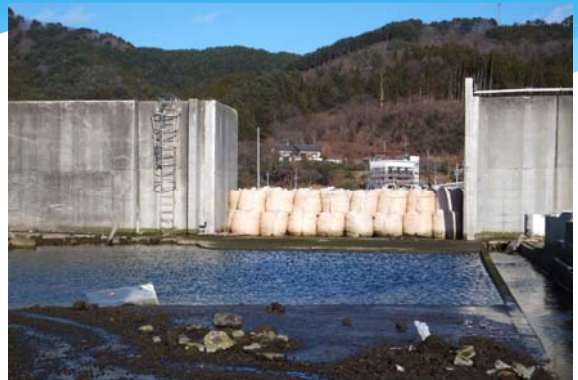
現在の大槌町の様子10 流失した水門の手前は地盤沈下により 常に海水が浸水している
