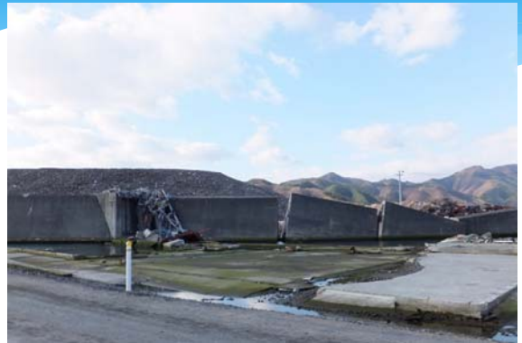
現在の大槌町の様子4 倒壊した防潮堤と土砂山
