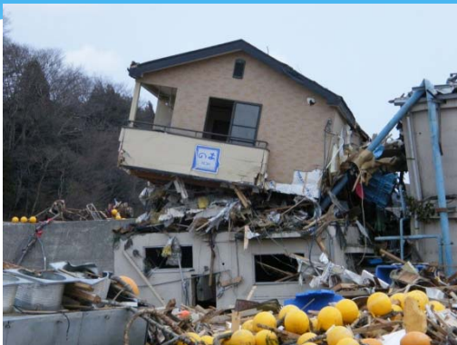
写真3 流された美容室の2階部分
