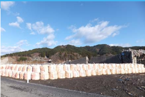
現在の大槌町の様子5 仮設防潮堤
