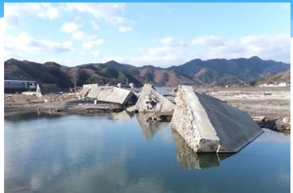
現在の大槌町の様子6 被災時のままの倒壊防潮堤
