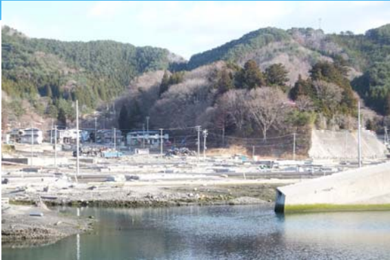
現在の大槌町の様子7 倒壊防潮堤付近から望む安渡地区 奥に仮設屯所がある
