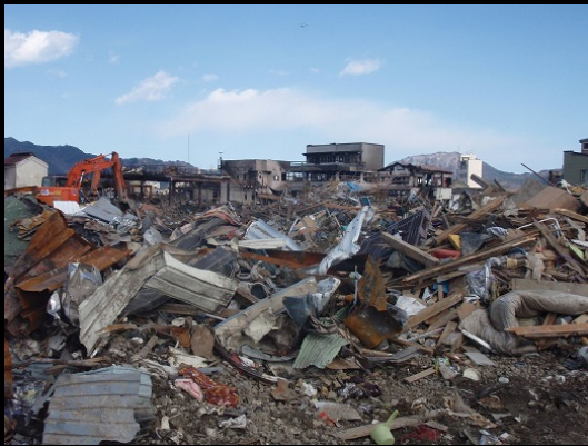
多くの瓦礫で幹線道路での出場はできなかった(写真は3月末撤去中)
